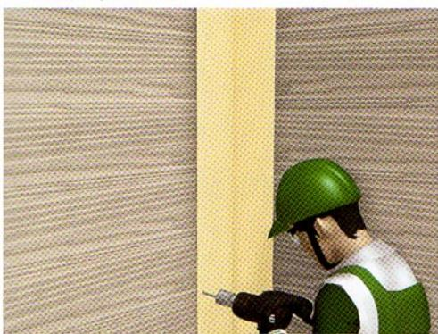
3. ติดตั้งแผ่นปิดมุมเมอร์ด้วยสกรูเมอร์ Fix-T 1 ½" ในกรณีที่เป็นโครงเครื่ง ไม้ หรือ Fix-W 45 ในกรณีที่เป็นโครงเครื่งเหล็ก โดยยึดสกรูเมอร์ทั้ง 2 ด้าน ให้ห่างจากขอบประมาณ 2 ซม. และห่างจากขอบล่างไปฝ้า ตราเมอร์ว่า 1 ซม.
