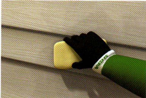
1. ตรวจสอบและทำความสะอาดบริเวณพื้นที่ของสีแล้ว ตราเมื่อว่า ให้ปราศจากฝุ่นละออง คราบไขมัน และเศษญี่ปุ่น ด้วยน้ำสะอาด ปล่อยไว้จนแห้งทั้งสนิทก่อน
