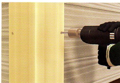
3. ติดตั้งแผ่นปิดมุนเหล็กเอนอร่าชั้นใน ด้วยสกรูเมอร่า Fix-T 1 ½" ในกรณีที่เป็นโครงเครื่าร้าไม้ หรือ Fix-W 45 ในกรณีที่เป็นโครงเครื่าเหล็ก โดยยึดสกรูเมอร่าห่าง 2 ด้าน ให้ห่างจากขอบประมาณ 2 ซม. และห่างจากขอบล่างไปฟ้า ตราเมอร่า 1 ซม.
