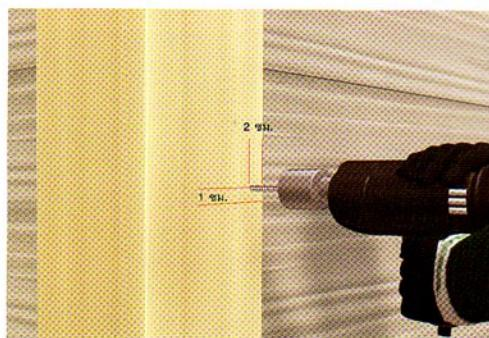
1. ใช้ส่วนเจาะหัวท่อแผ่นปิดมุนเหล็กเอนอร่าชั้นใน จนถึงโครงเครื่อง เจาะห่างจากขอบประมาณ 2 ซม. ห่างจากขอบล่างไปฟ้า ตราเมอร่า 1 ซม. เพื่อกำหนดจุดในการติดตั้ง
