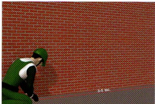
1. กำหนดระนาบของผนังขึ้นมาใหม่ โดยขึ้นเส้นที่หันให้ห่างจากผนังเดิม ออกมาก 3-5 ซม. ตลอดแนวความยาว
